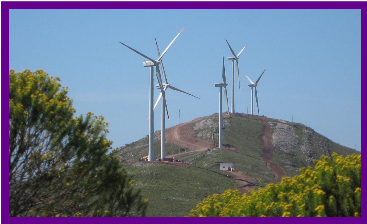
Energía eólica, Sierra de los Caracoles, departamento de Maldonado - Foto: MIEM
