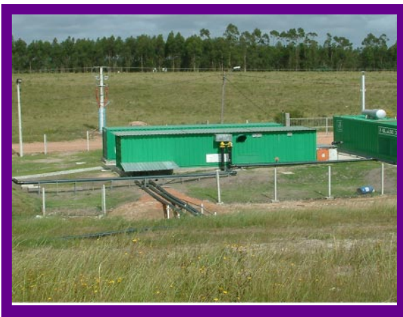
Planta de biogas, Maldonado - Foto: UCC - DINAMA
