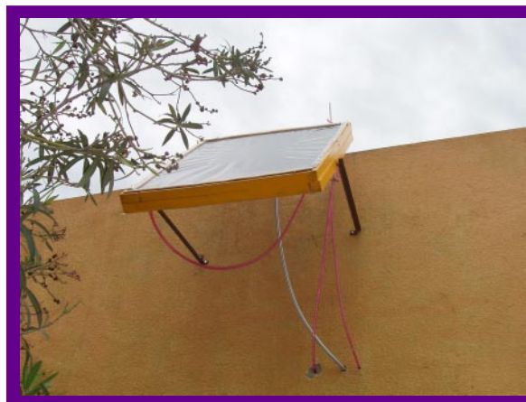
Panel solar autoconstruido, LaTAs, Liceo de Baltasar Brum, departamento de Artigas - Foto: Ceuta
